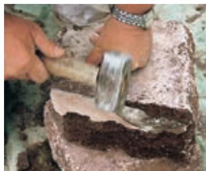
Nach dem maßgerechten Zuschnitt der Mauerblöcke können die Schnittflächen auf einfache Weise mit einem Fäustel oder Bossierhammer nachträglich bearbeitet werden.
