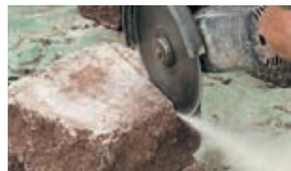
Steine gemäß dem gewünschten Kurvenradius anzeichnen und mittels Trennscheibe anschneiden
