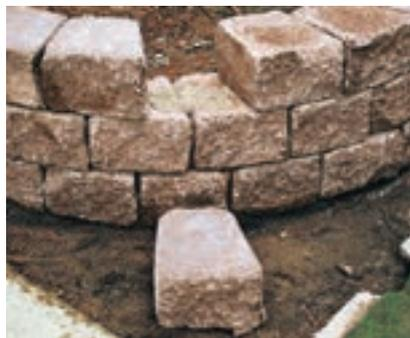
Die Steine sollten aus statischen Gründen mit einem Natursteinkleber verklebt werden. Zudem können leichte, fertigungsbedingte Höhentoleranzen durch den Naturkleber ausgeglichen werden.
